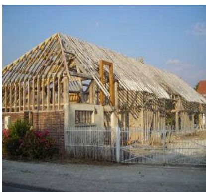
1 - Habitation ancienne en rénovation Rue de l'Eglise, Lépine
