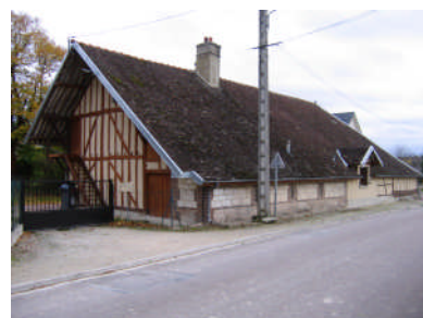
Habitat ancien rénové Rue Louis Guillemin, Hameau de Lépine
